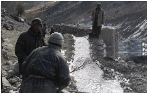
Wiederhergestellter Wasserkanal für eine Gerstenmühle
