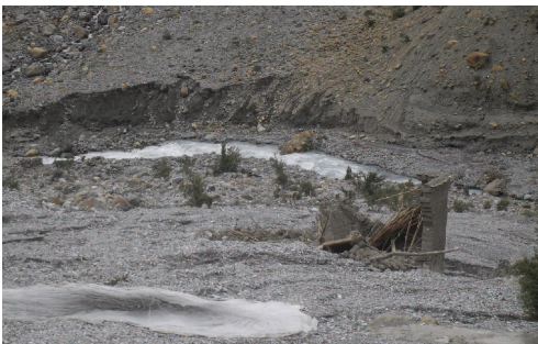
Von der Flut zerstörtes Haus
